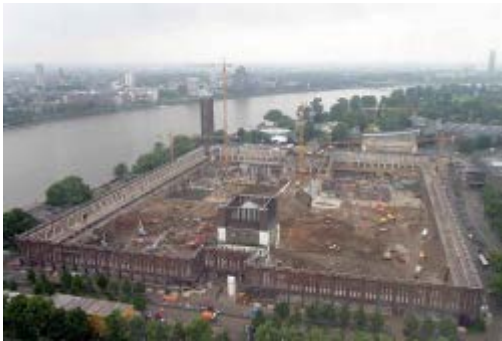
Die historischen Messehallen während des Umbaus
